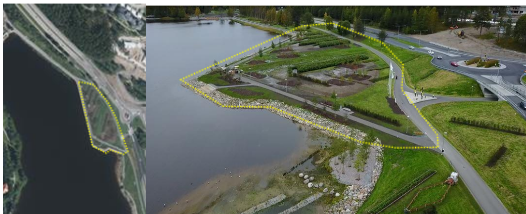
Figur 12. Utfyllnad för förvaring av sulfidjord under vatten, i Skurholmsfjärden, Luleå.
