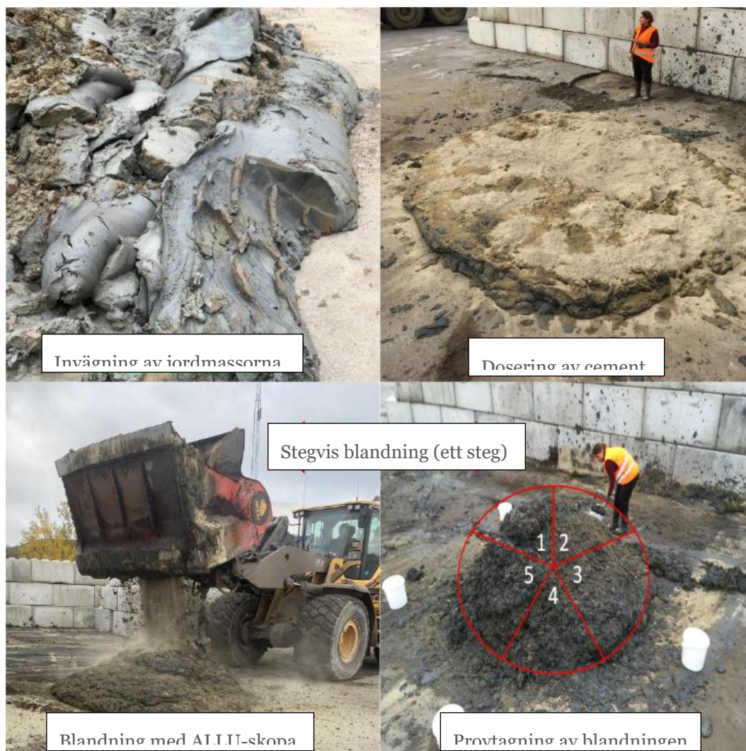
Figur 38. Procedur för utförande av fältblandning. Bilder hämtade från Ziagharib (2023). Foto: Alaleh Ziagharib.
