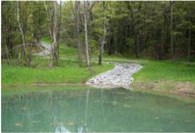
Figur 14. Anläggning för behandling av surt lakvatten genom kalkning av bäckfåran. Bild: Ramboll Sweden AB.
