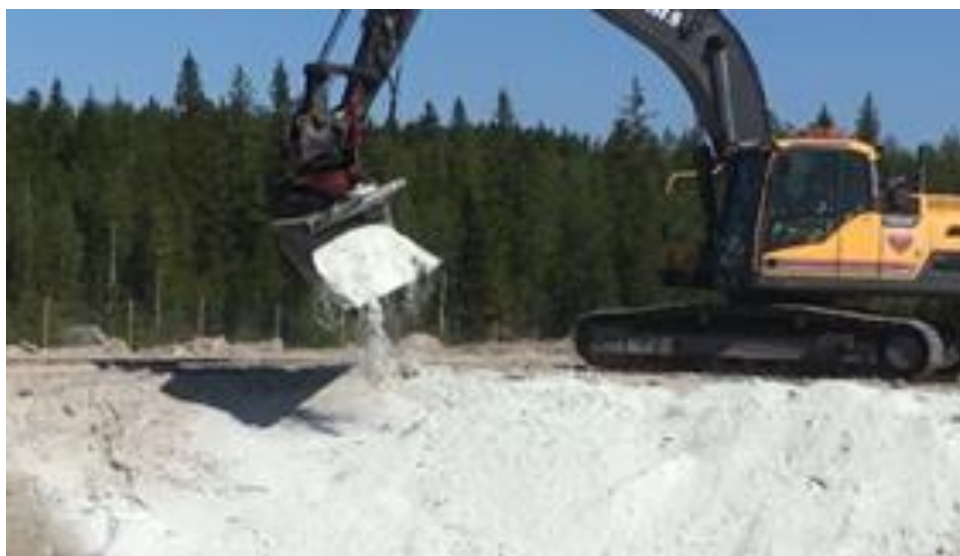
Figur 13. Deponering av sulfidjord i delvis saturerade celler vid Dåva DAC, Umeå. Kalkning av cellens sidor med Mesa.
